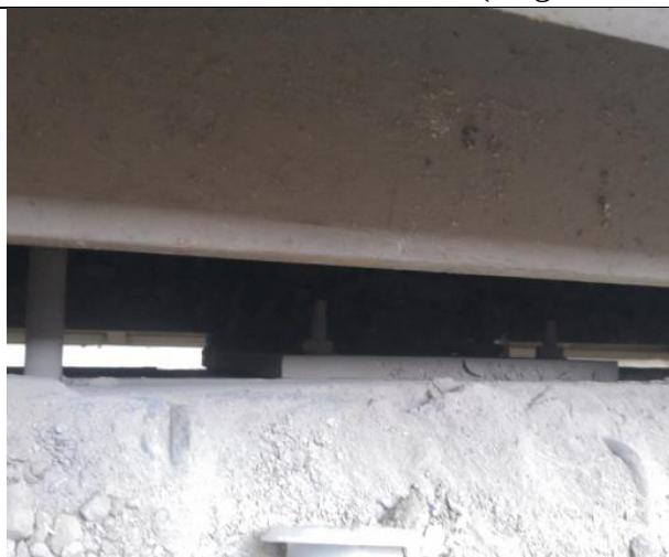
照片 8: 钢梁侧面螺栓及梁托
