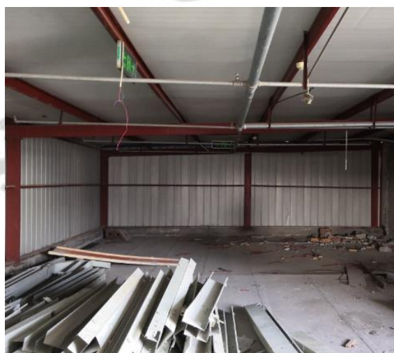
照片 9: 四层加建钢结构
