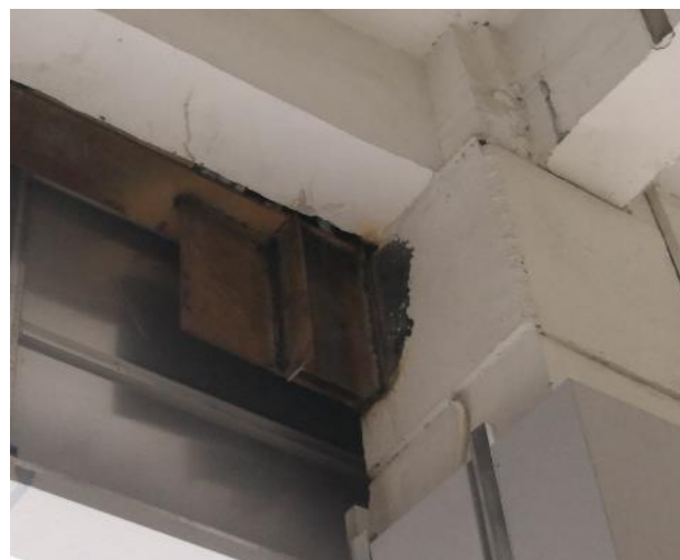
照片 6: 钢梁端部 1
