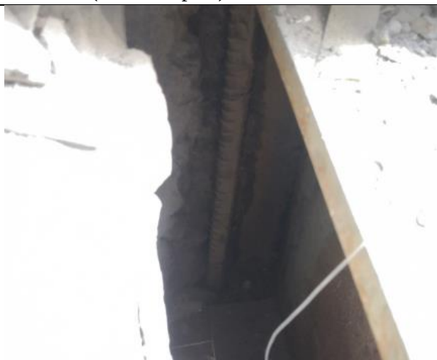
照片 7: 钢梁端部 2
