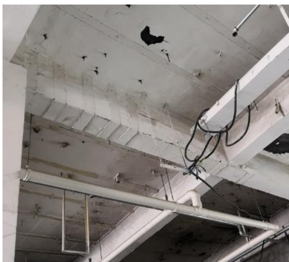
照片 14: 粘钢梁、板
