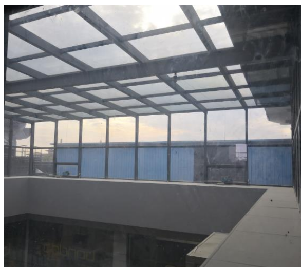
照片 11: 四层中庭处钢结构阳光房-内景
