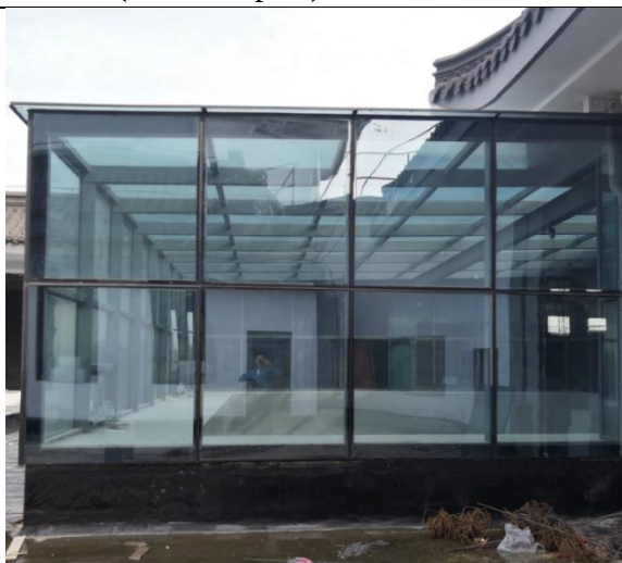
照片 12: 四层中庭处钢结构阳光房-外景
