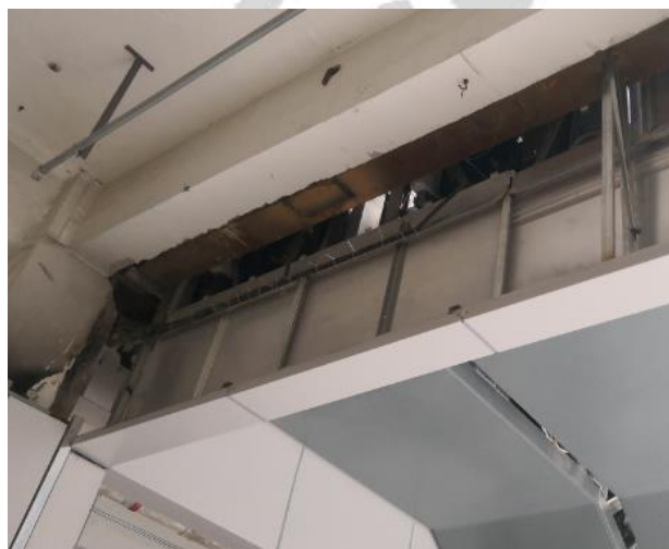
照片 5: 扶梯端部钢梁
