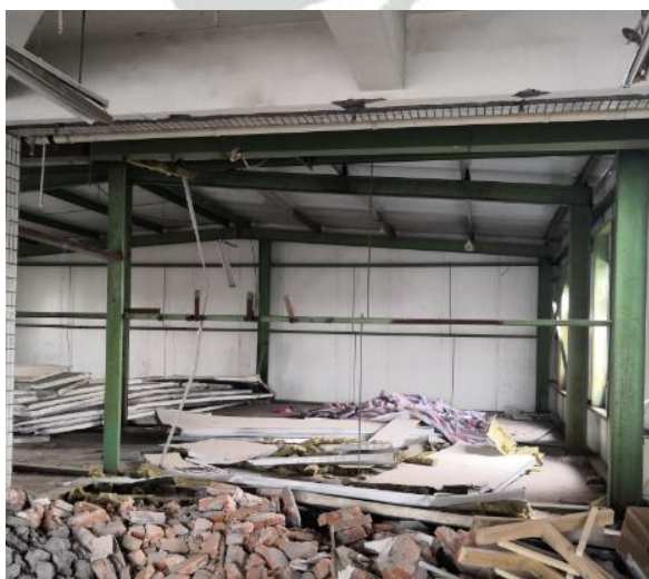
照片 10: 机房层加建钢结构
