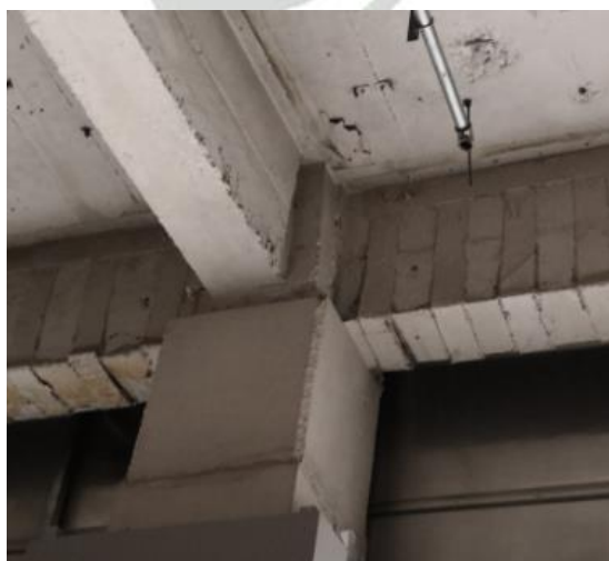
照片 16: 加固-柱顶 1
