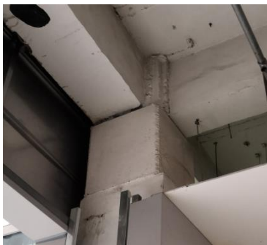
照片 17: 加固-柱顶 2
