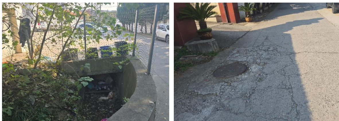
沿线暗渠、管道
