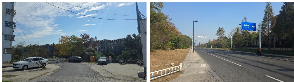
交叉口警告标志设置错误
